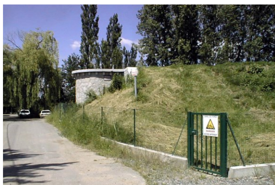
Clôture autour d'un siphon à SAVIGNEUX
