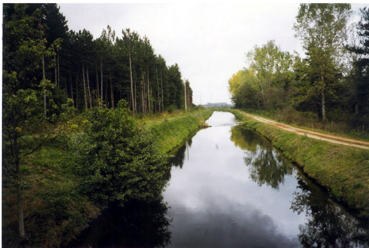
Branche Principale du Canal du Forez à ST MARCELLIN-EN-FOREZ
