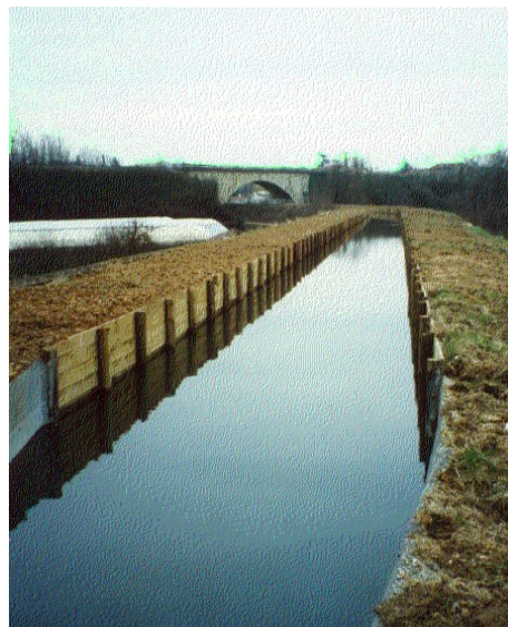
Tronçon de l'Abbaye à Savigneux tunage (revêtement bois)
