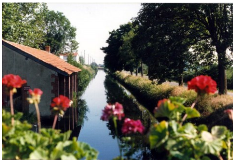
Branche Principale du Canal du Forez à SAINT ROMAIN-LE-PUY
