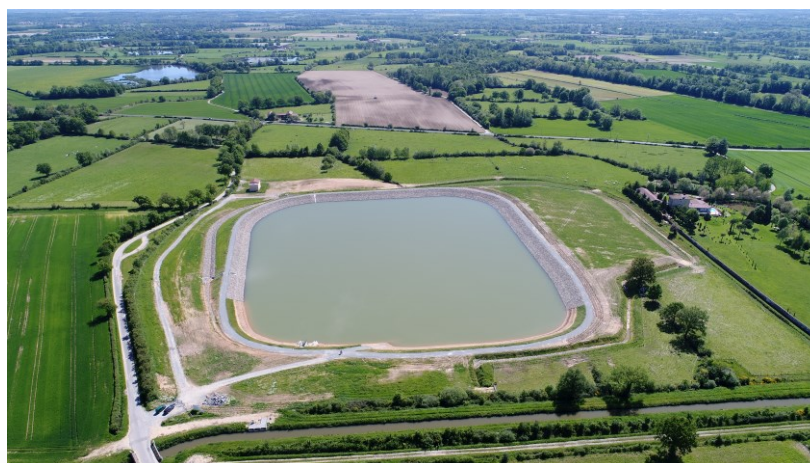
Retenu de stockage d'eau de Villeroy à Champdieu
