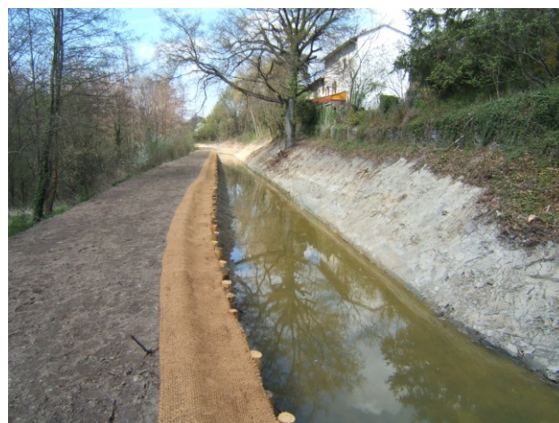
Tunage (revêtement bois) à CHAMPDIEU
