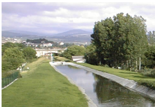
Revêtement par béton projeté à SAVIGNEUX
