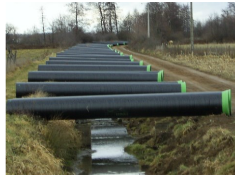
Canalisation Artère de l'HOPITAL Travaux 2005 - Pose tuyaux
