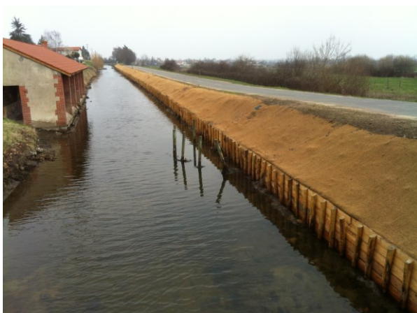
Tunage (revêtement bois) à ST ROMAIN LE PUY
