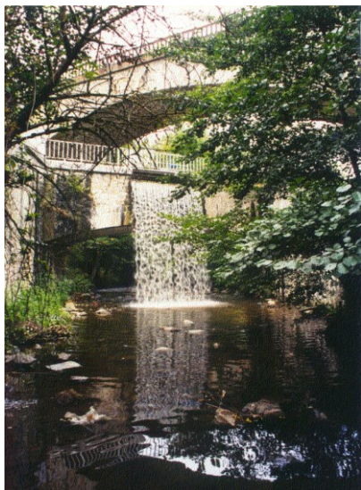
Pont-canal sur le Vizézy
