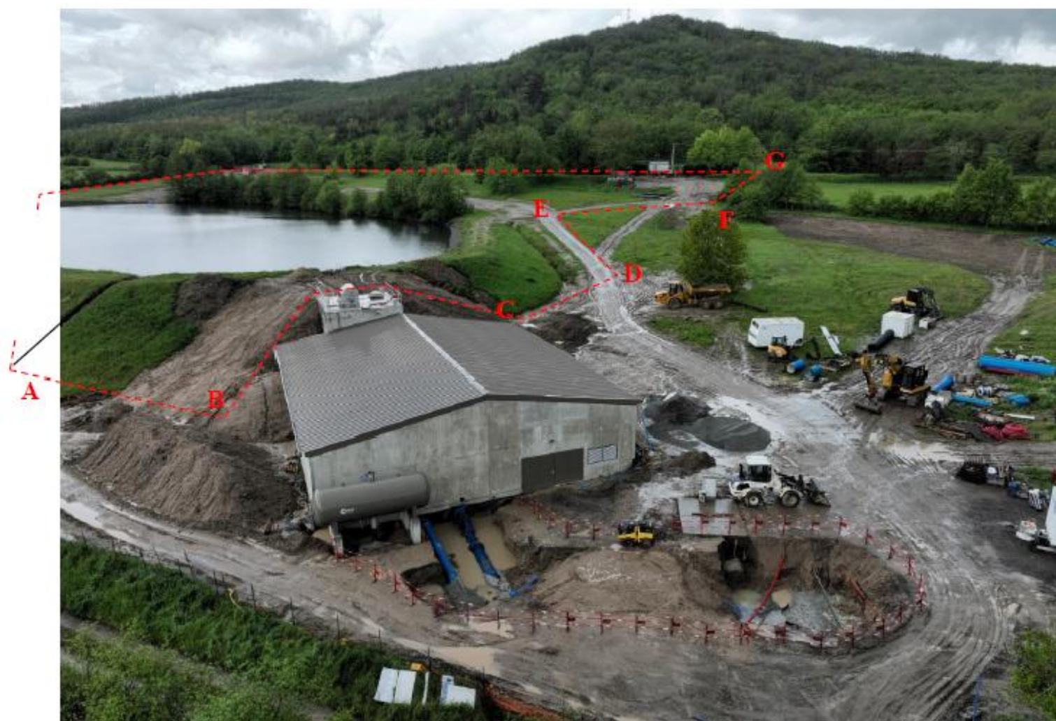
Vue du site lors des travaux (photo SMIF)
